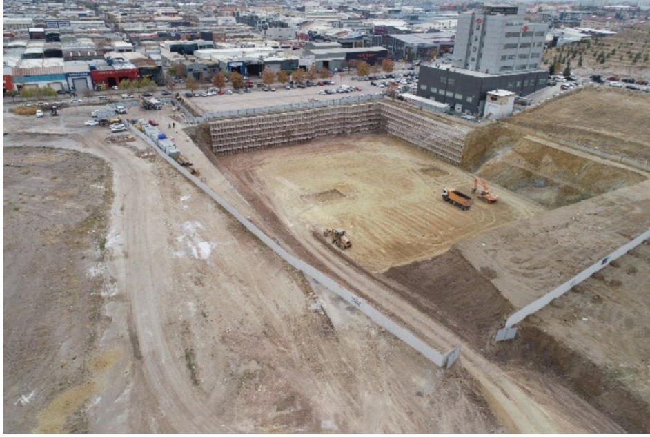
Görsel 3: Üçüncü Nesil Kampüs Projesi A Blok Mühendislik Fakültesi temel kazımı.
