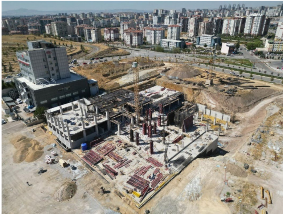
Görsel 3: Üçüncü Nesil Kampüs Projesi A Blok Mühendislik Fakültesi kaba inşaatı.
